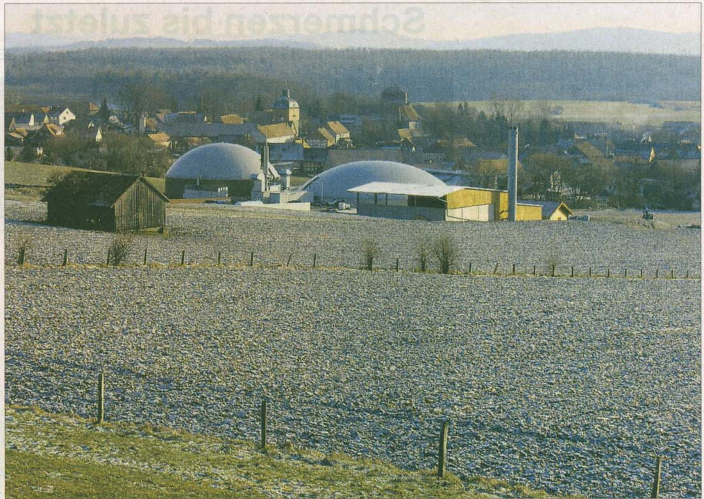
Zwischen dem Dorf Jühnde und winterlichen Feldern erhebt sich der Energiepark: Die linke Kuppel gehört zum Fermenter, der Schornstein daneben zum Blockheizkraftwerk. Ganz rechts steht das Holzschnitzel-Heizwerk. Foto: Jarke
